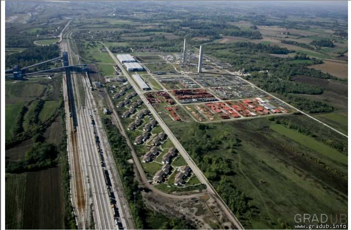
Термоелектрана Колубара Б – у изградњи
